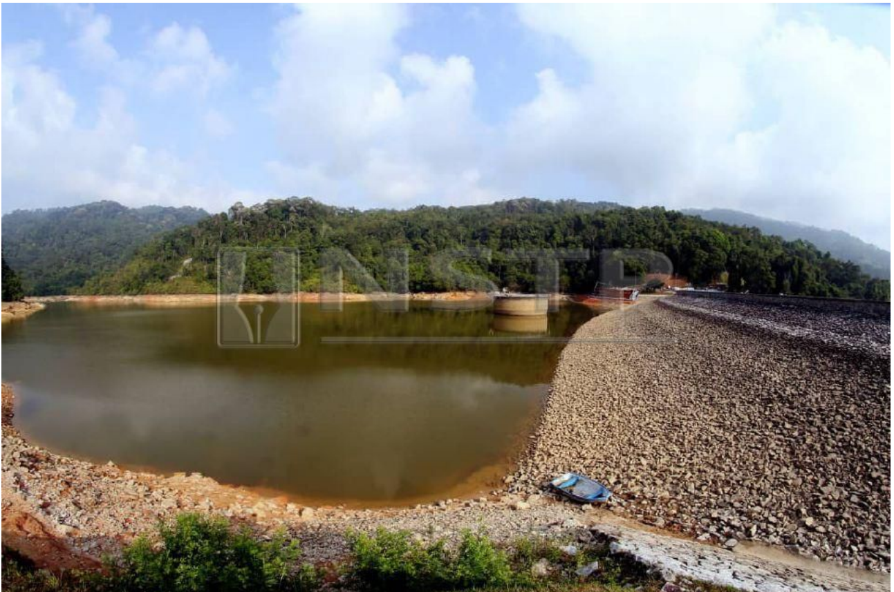
CUACA panas dan kering di Empangan Air Itam menyebabkan air mentah untuk memenuhi keperluan bekalan air di Bandar Air Itam, Lembah Paya Terubong dan kawasan sekitarnya selama 48 hari lagi. - Foto Mikail Ong
